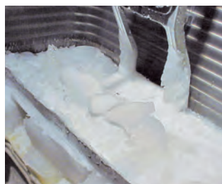
Oblodzenie urządzenia zewnętrznego bez ogrzewania tacy
